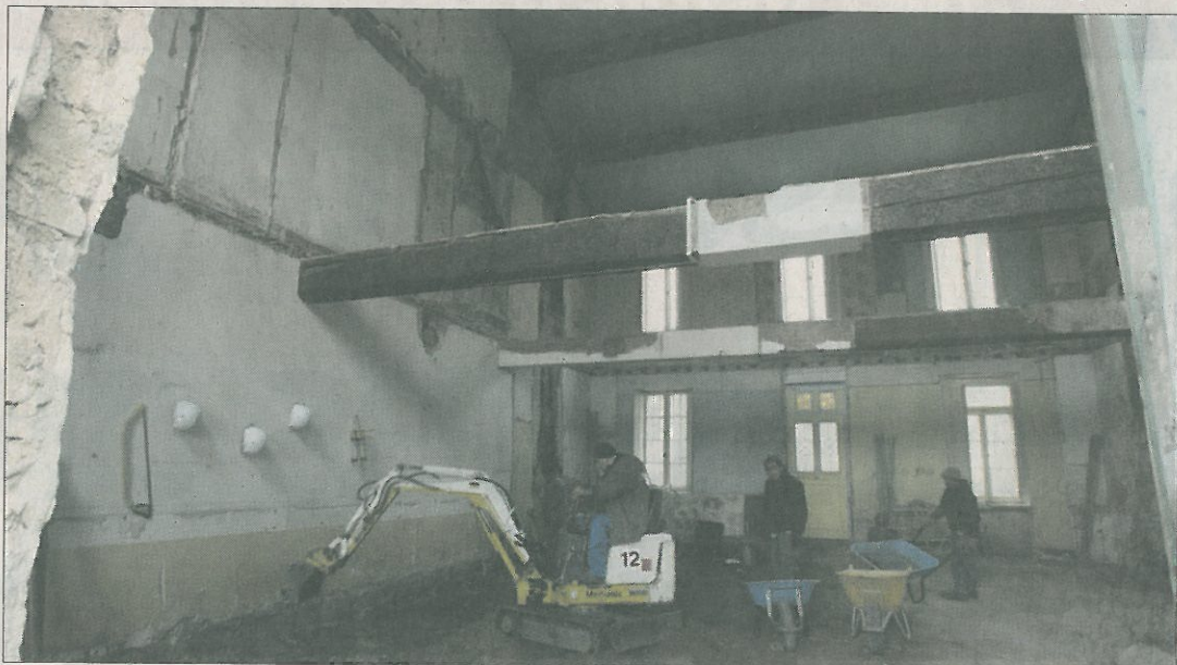
Le futur CHRS disposera de 18 places à partir d'octobre 2011. Les travaux ont débuté. Ph. Cl. B.
